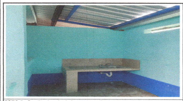
FOTO 5: Sustitución de lavatrastos (incluye mezcladora)
