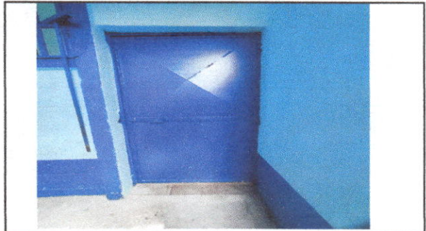
FOTO 2: Sustitución de puerta de 2x1mts EN COCINA
